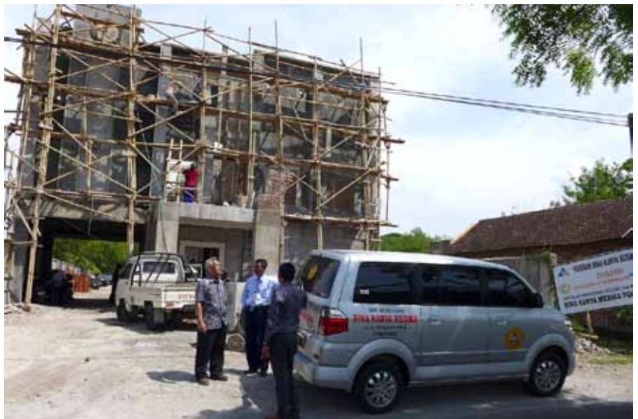
Gedung SMK Kesehatan Bina Karya Medika Ponorogo yang sedang dibangun.
